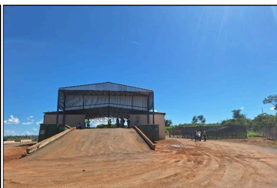
Rampa para entrada de caminhão de coleta. Autoria: Luísa Mosqueira Data: 21/01/2025
